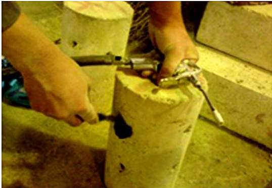
شکل ۴: تمیز کردن سوراخ توسط برس
